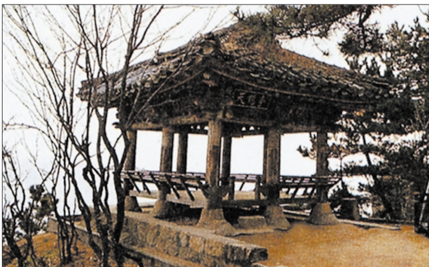
보수 전 천학정
