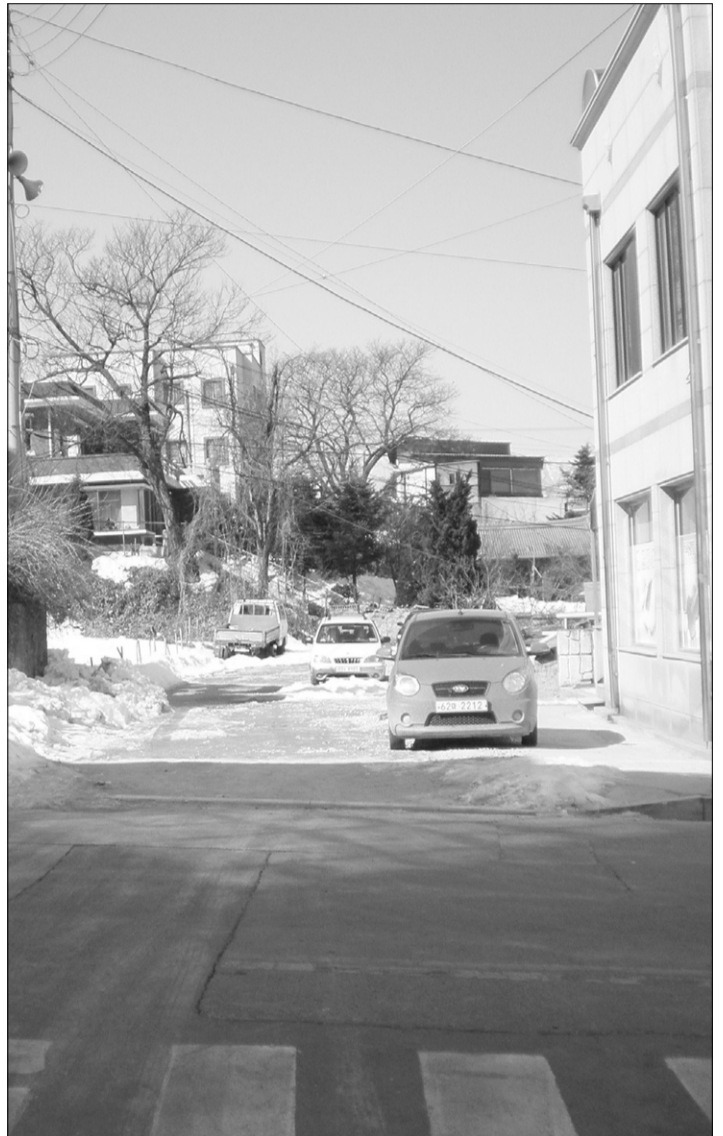
간성읍 신안리 간성우체국~성원전업사 구간 도시계획도로 중 포장이 안되고 있는 허버드 학원~멜로지아 음악학원 구간.
