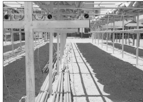
고성군이 설치한 해풍건조시설이 전통 덕장 방식과 달라 효율성이 떨어진다는 지적을 받고 있다. 파이프 두개로 덕을 만들었다가 불편하자 한개를 제거해 바닥에 내려놓았다.
