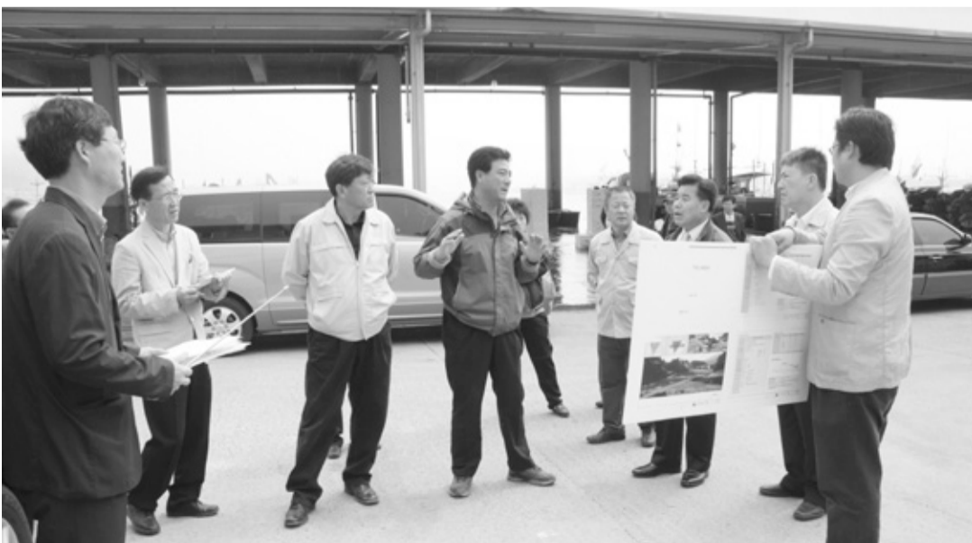
고성군의회 의원들이 대진리 고성군수협 현장사무실 앞 항포구내 주변시설 정비사업 현장을 찾아 철거과정에서 민원이 발생하지 않도록 해달라고 주문했다.
