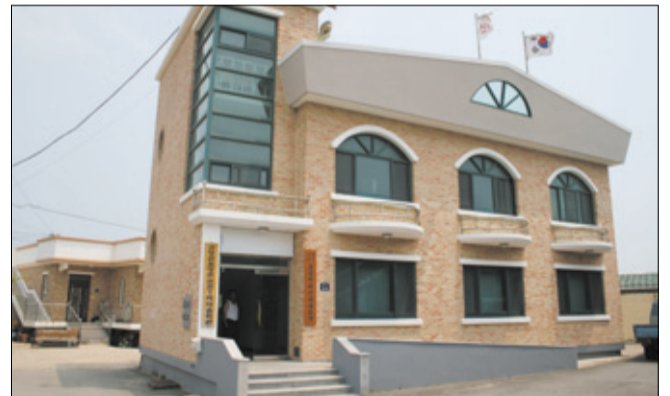
토성면 천진리 경로당 전경.
