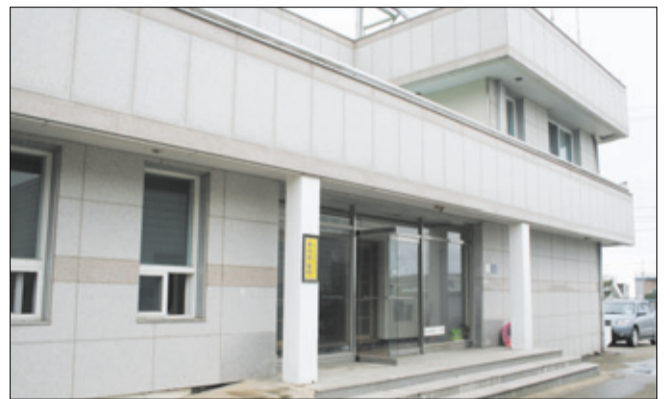
현내면 초도2리 경로당 전경.
