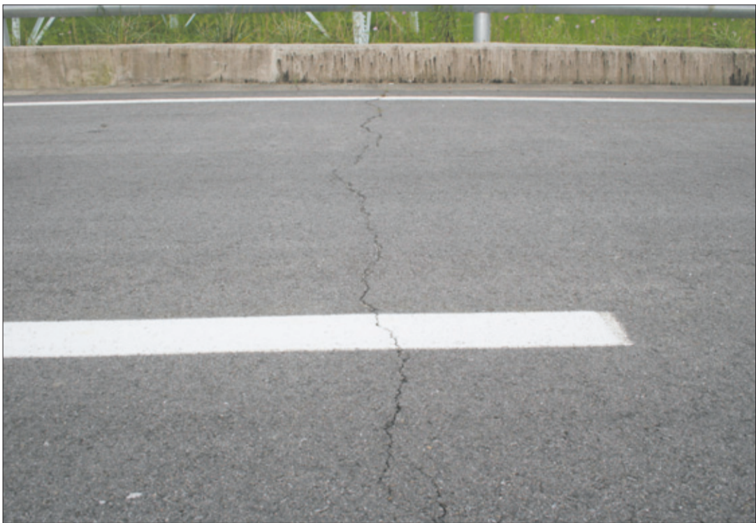
지난 2009년 시공된 농어촌도로 101호와 간촌교 접속도로 확포장 사업 구간에 5~10m마다 횡으로 크랙이 생겼다. 이의 원인으로 재활용골재인 A제품을 기층재로 사용했기 때문이라는 지적이 나오고 있는 가운데, A제품을 생산하는 업체 관계자는 시공사의 잘못이라는 주장을 제기해 책임 소재를 놓고 논란이 일고 있다.
