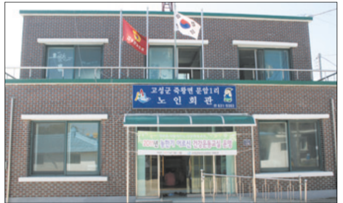
죽왕면 문암리 경로당 전경.
