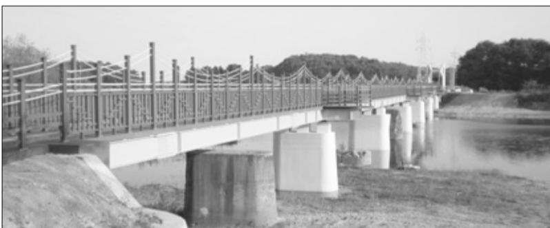
한국전쟁 당시 파괴된 후 방치되고 있던 ‘북천철교’ 자리에 평화통일을 염원하는 의미를 담은 자전거전용 교량이 설치됐다.
