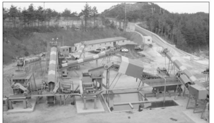
고성지역 대표적인 종합건설폐기물 중간처리 전문업체인 미성환경 작업장 전경.
