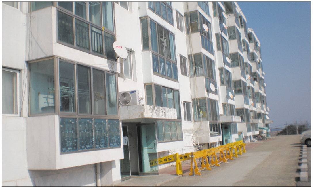
간성 군인아파트가 지어진지 30년 가까이 돼 노후되자 22사단이 신축 아파트를 건립해 이전하는 사업을 추진하고 있다. 사진은 지난 15일 군인아파트 현장 모습. 사단 공병대에서 콘크리트 구조물 낙하에 의한 사고를 막기 위해 임시로 안전막을 설치했다.
